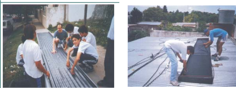
El calefón solar construido con alumnos de 6º grado de la Escuela Nuestra Sra. de Lourdes de la ciudad de Paraná. En la primera foto se observa el trabajo con alumnos y en el segundo colocando los primeros metros de caño.
